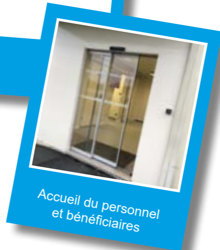
MISE EN PLACE DE PORTES AUTOMATIQUES
